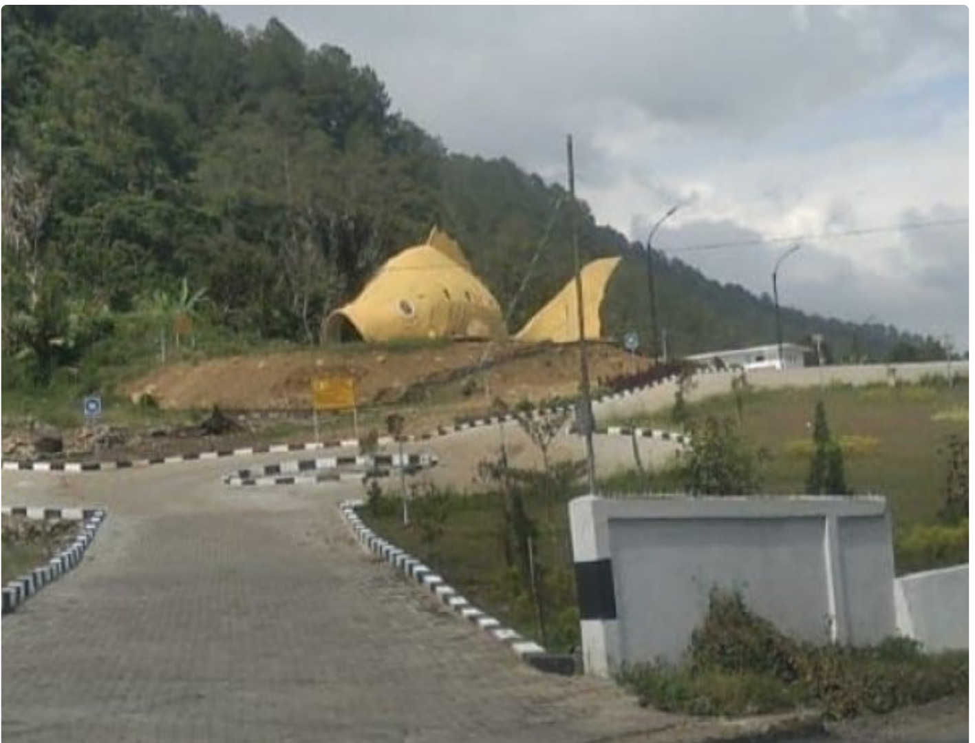
Proyek Pembangunan Ikan Mas Sipolha
