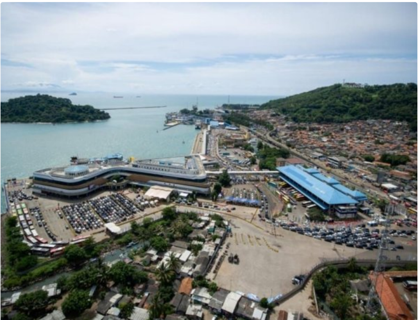
Kondisi antrean kendaraan di pelabuhan Merak
